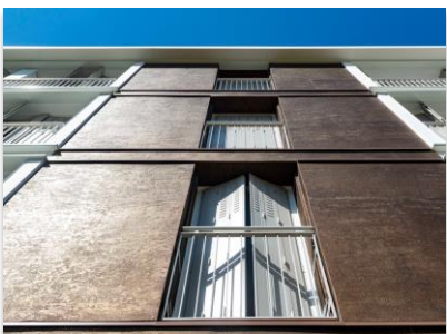
La résidence du Moulin Vert à Sannois (95) Pour obtenir l'aspect béton de l'enduit sur isolant, plusieurs étapes doivent s'enchaîner. Crédit photo : Manuel Panaget
