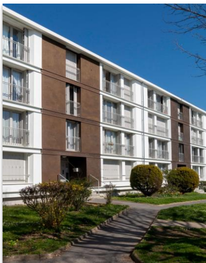
La résidence du Moulin Vert à Sannois (95) Pour mettre en œuvre cet enduit innovant à l'aspect béton, l'entreprise GCEB a bénéficié de l'accompagnement de Sto sur le chantier. Crédit photo : Manuel Panaget
